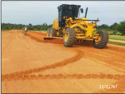
กิจกรรมก่อสร้าง Subbase for Railway
