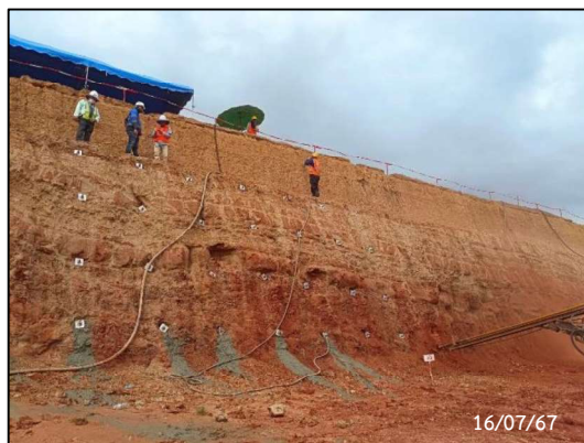
กิจกรรม Soil nail for Slope Protection
