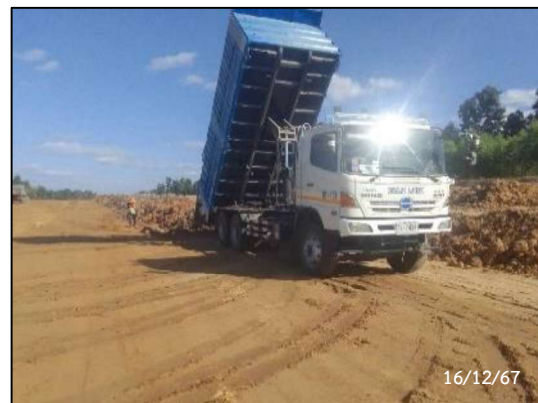
กิจกรรมก่อสร้าง Soil Replacement Fill from Imported Material
