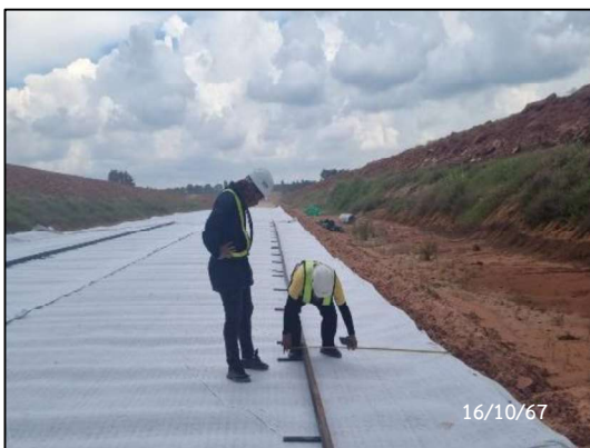
กิจกรรม Geocomposites for Sand Drain
