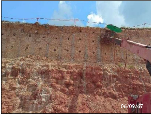
กิจกรรม Shotcrete with Soil Nailing for Back Slope
