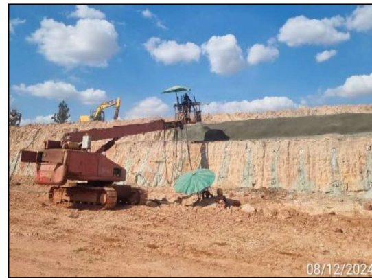
กิจกรรม Soil nail for Slope Protection (ต่อ)
