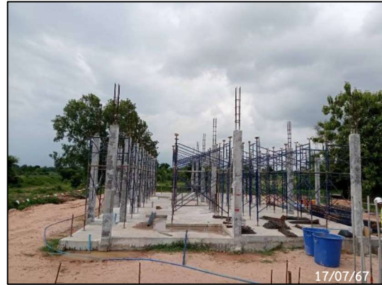
กิจกรรม ติดตั้งนั่งร้านเตรียมงานคาน ชั้น 2 อาคาร B14 - (Staff House Building Type 03)
