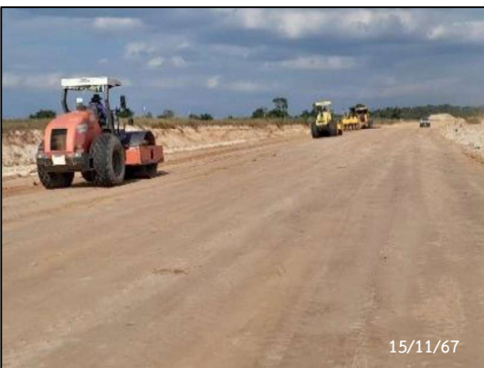
กิจกรรมก่อสร้าง Soil Replacement Fill from Imported Material
