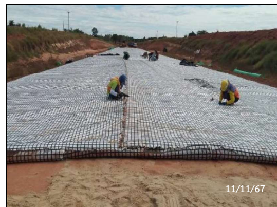
กิจกรรม Geocomposites for Sand Drain
