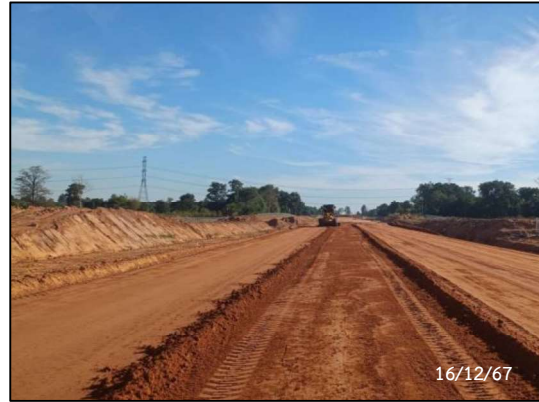
กิจกรรมก่อสร้าง Subbase for Railway
