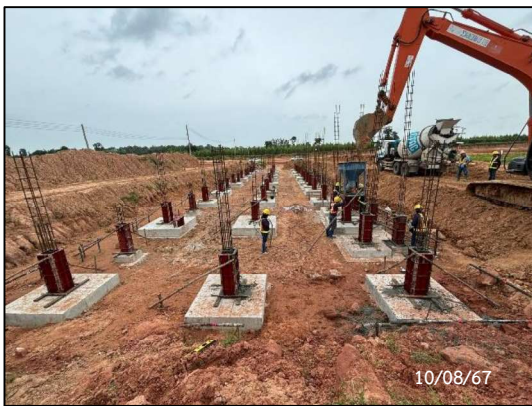
กิจกรรม งานเทคอนกรีตเสาตอม่อ อาคาร B13-1, B13-2 และ B13-3 สถานีภูเหล็กอาคาร B14 - (Staff House Building Type 03)
